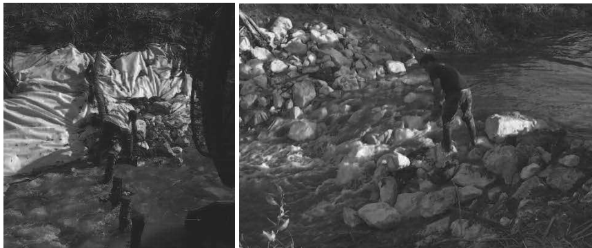
Figura 18 - Exemplo de micro-açudes em pedra a construir ao longo do traçado para evitar a incisão e promover a melhoria das condições dos habitats
